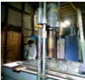
取り外される第3号の酒槽
